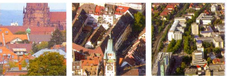
Über den Dächern von Freiburg schlummert ein enormes Solarenergiepotenzial.
